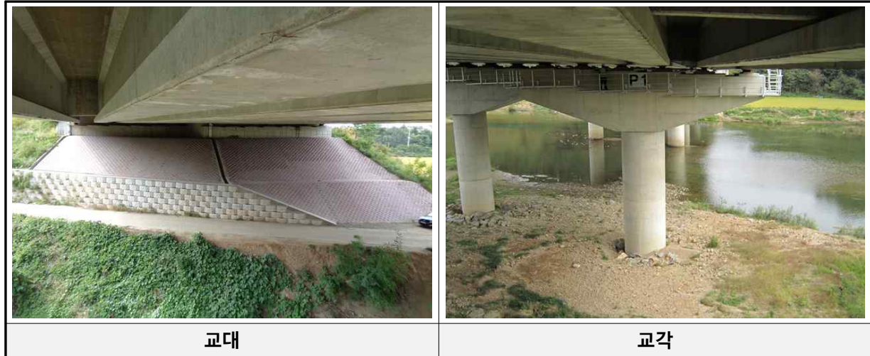
[교대 및 교각 전경]
